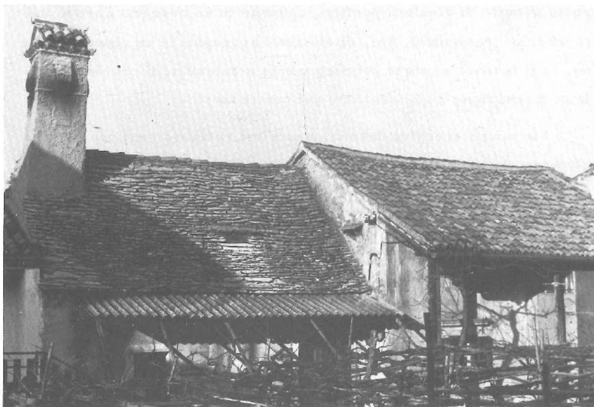
Fig. 1 - Raro esemplare di costruzione arcaica (57/2/MON 2), con tetto spiovente in lastre di pietra locale. La struttura era in legno con le travi portanti collegate ad X, sulla cui parte incrociata superiore era collocata la trave di colmo. Il resto dell'orditura portante era in legno duro irregolare, ricavato da rami spesso contorti e abbruciacchiati per aumentare con la carbonificazione superficiale la resistenza all'umidità. Presente una canna fumaria di notevoli dimensioni e di accurata fattura, avente alla base sezione leggermente maggiorata rispetto al resto. Anno 1984. (Foto P. Marchesi).
