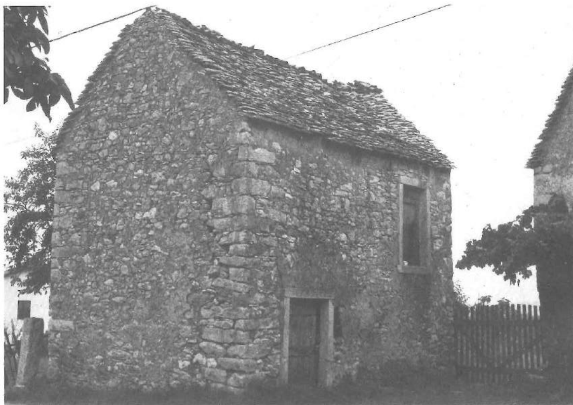
Fig. 3 - Vanja Strukelj, con la schedatura del novembre 1980, riportava l'esistenza del semplice e caratteristico edificio di Sgonico (179/89/MON 7), costruito in pietrame scapolo con conci maggiori rozzamente squadrate agli angoli e copertura ripida in lastre calcaree. (Foto V. Strukelj).
